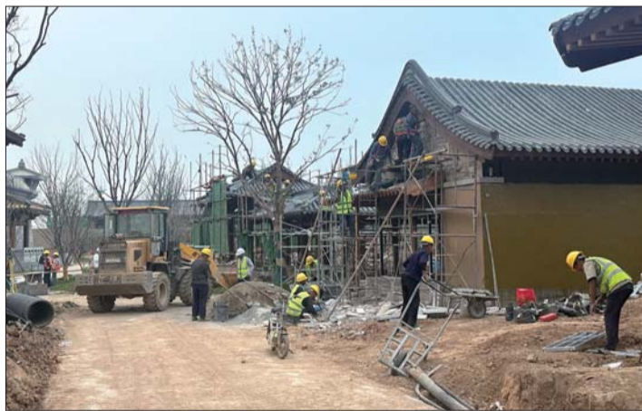
工人们正在加紧施工。
