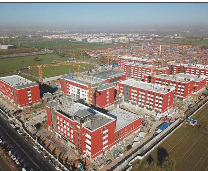
山东新英才职业高中项目建设现场。
