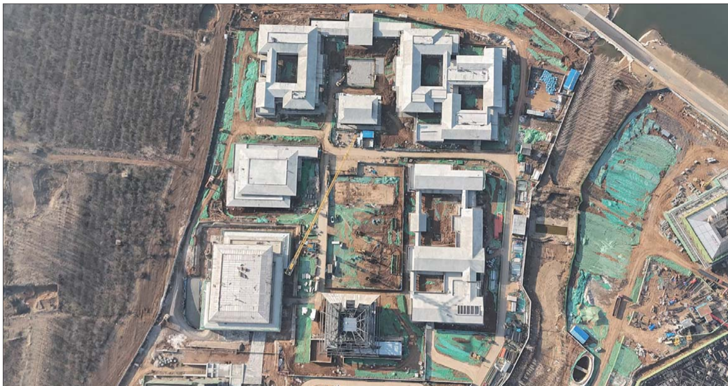
鸟瞰尼山世界儒学中心联合研究生院项目建设现场。
