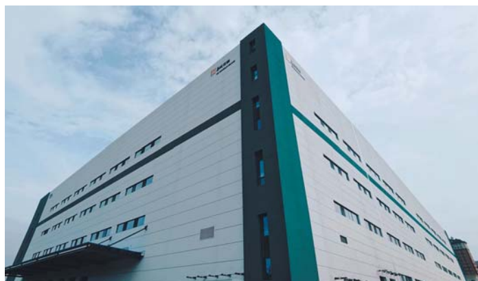
华润双鹤利民固体制剂车间项目。
