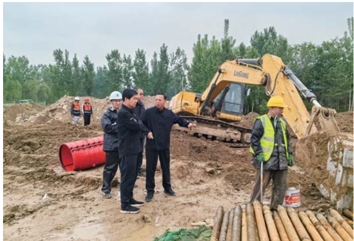
区委常委、副区长李宪亮察看供水管网施工现场。
