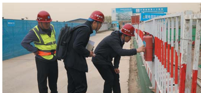
崔寨街道开展安全生产检查工作。
