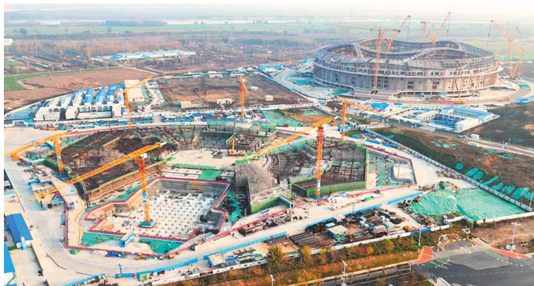
济南黄河体育中心项目建设现场。
