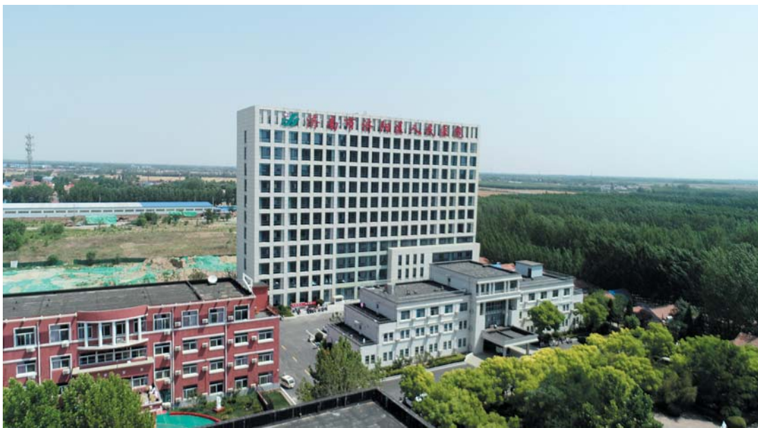
老院区医养楼
