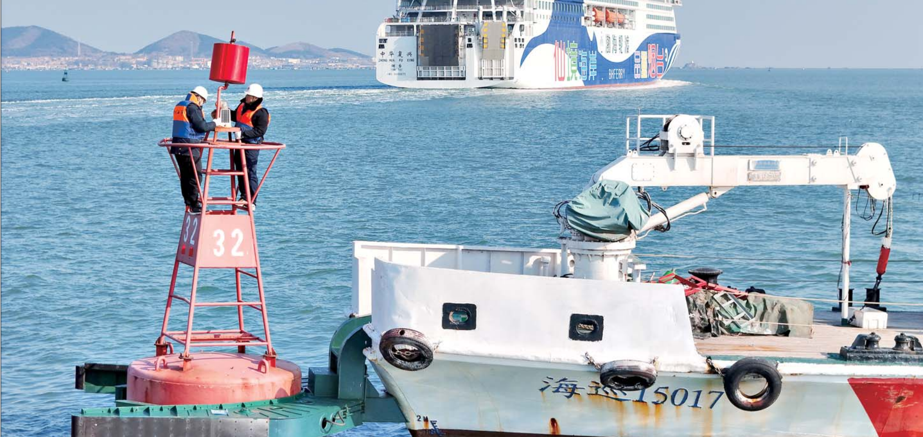
1月12日,烟台航标处工作人员在山东烟台海域检修灯浮标(无人机照片)。春运临近,各地加强交通运输设施设备检查维修,守护春运安全。
