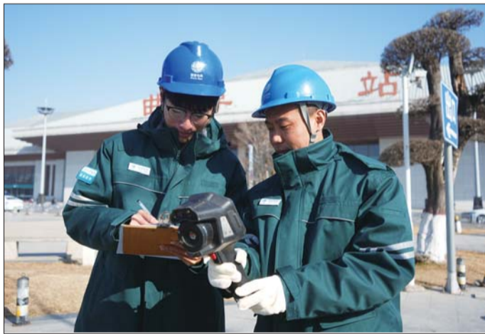
工作人员在巡查曲阜东站供电。
