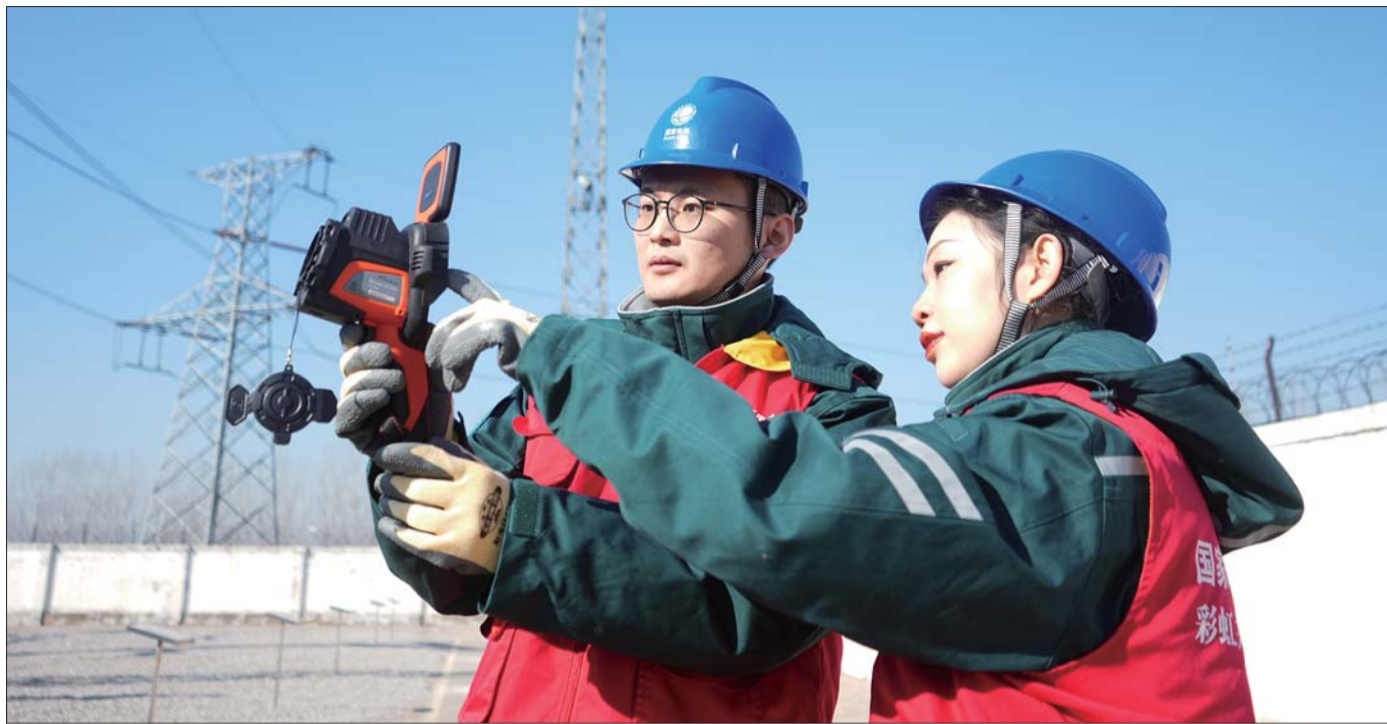
秦贞依和同事正在进行电路排查。
