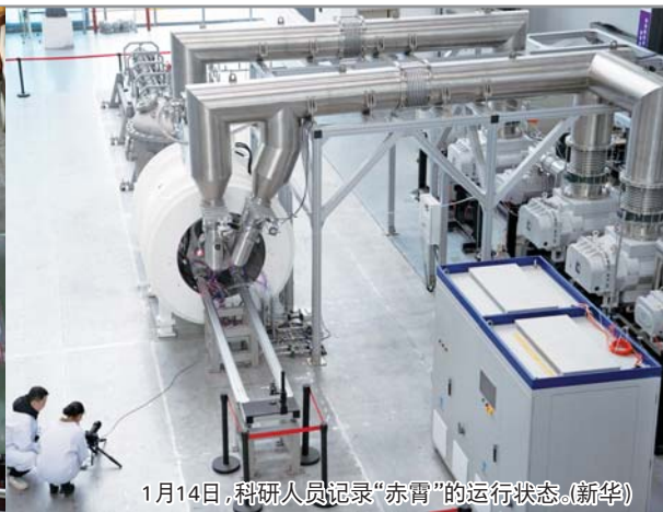
这是1月16日拍摄的全超导托卡马克核聚变实验装置(EAST)。(新华社)
