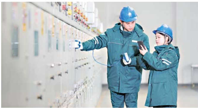
供电员工在所辖变电站利用超声波局部放电监测仪开展设备巡检。 陈彬 摄
