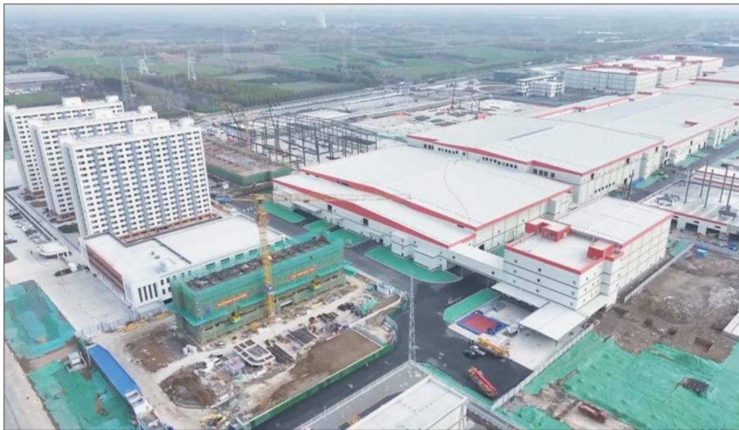
山东时代新能源电池产业基地项目现场。
