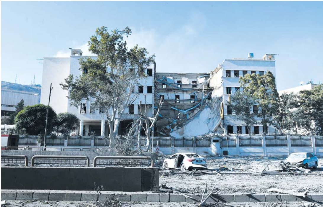
这是7月16日在叙利亚首都大马士革拍摄的在以色列空袭中受损的叙“总参谋部”大楼。 新华社发
