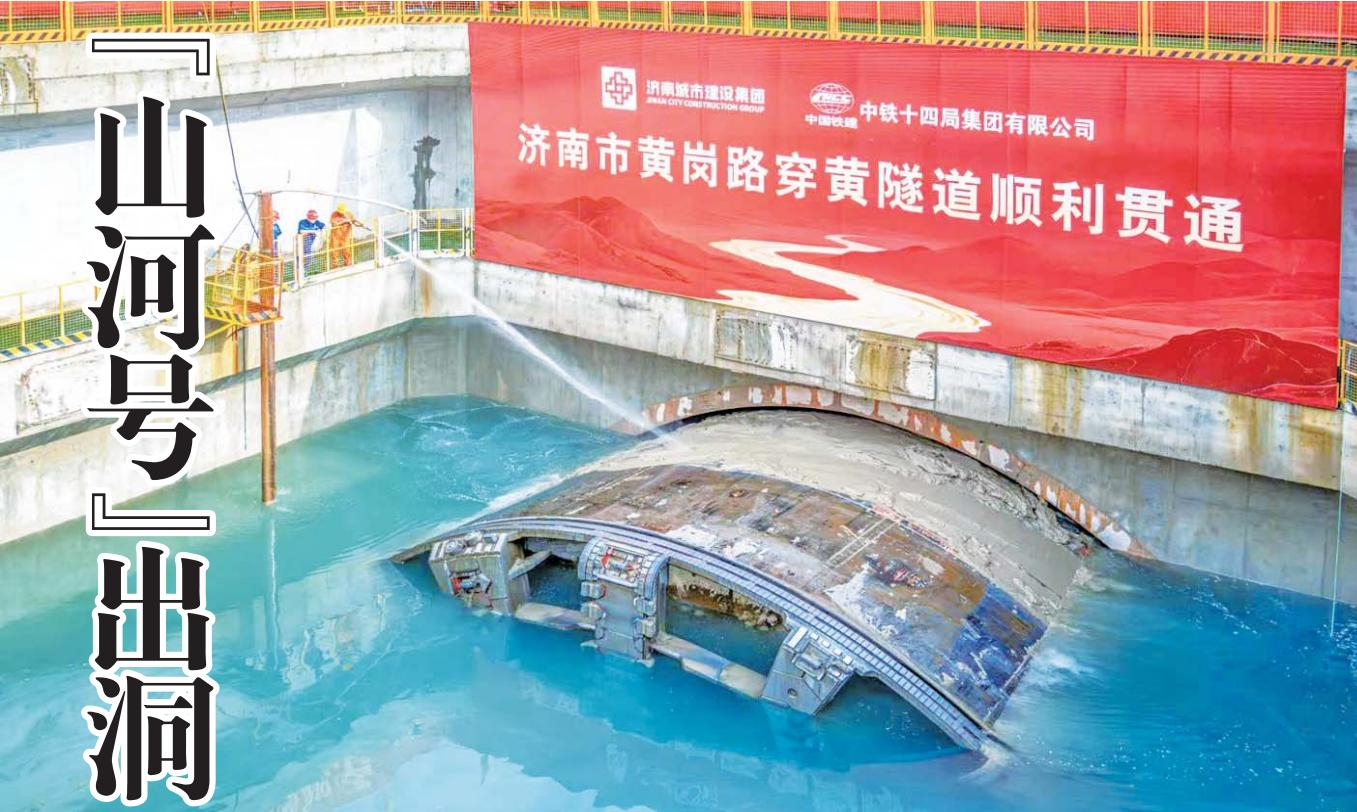
8月17日,黄河济南段地下30米处,随着开挖直径17.5米的“山河号”盾构机刀盘破洞而出,世界最大直径水下盾构隧道——济南黄岗路黄河隧道贯通,标志着中国水下隧道建设领域迎来里程碑式突破。中铁十四局项目现场负责人周祥介绍,17米级盾构机首次穿越“地上悬河”,施工难度大、要求高,对掘进的精准管控和设备可靠性提出了极高要求。记者 王瑞超 于泊升 报道 受访者供图 [详见A05版](#)
