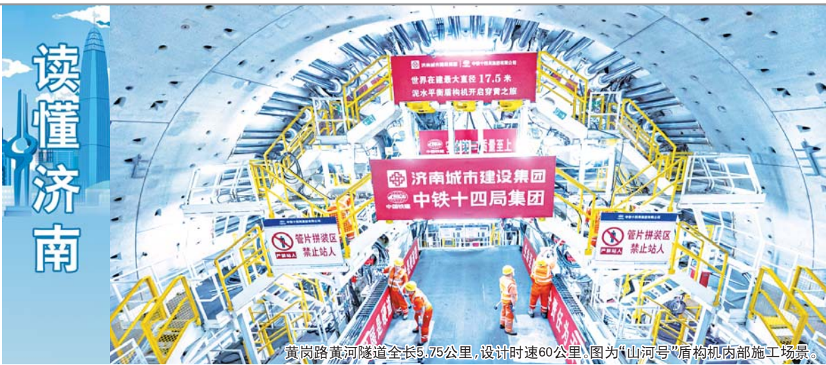
黄岗路黄河隧道全长5.75公里,设计时速60公里。图为“山河号”盾构机内部施工场景。
