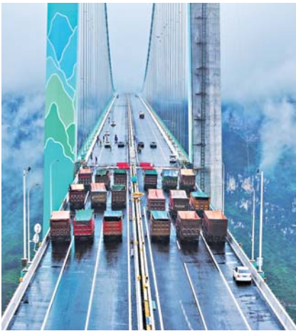
8月21日拍摄的贵州花江峡谷大桥荷载试验现场(无人机照片)。 新华社发
