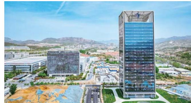
化光伏玻璃幕墙,如同为大楼披上了一层“发电外衣”。这些幕墙所产生的直流电可直接供给大楼内部使用,避免了交直流转换过程中的能量损耗,仅光伏一项就可满足整栋建筑约25%的用电需求,年减碳量近500吨。
