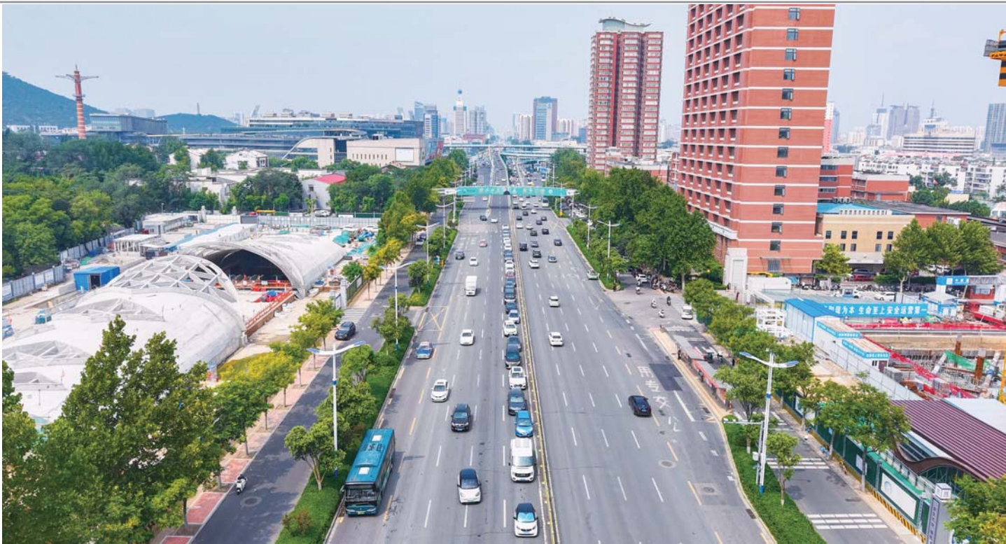
济南地铁4号线经十路南侧的泉城公园站(工程名),为地下水让路,车站浮出了地面。
