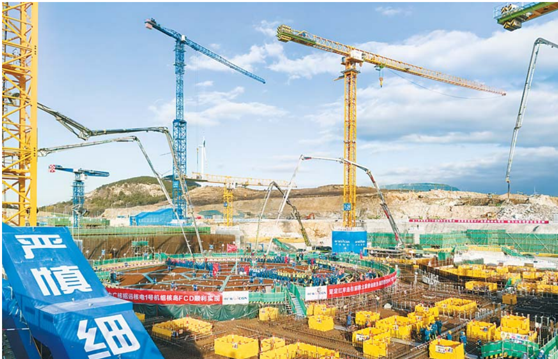
中广核山东招远核电项目1号机组核岛进行混凝土浇筑。
