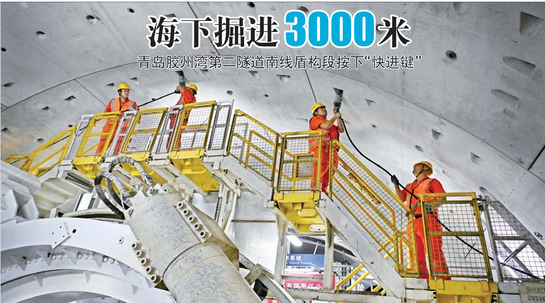
12月15日,青岛胶州湾第二隧道南线主线隧道盾构段成功穿越多条海底破碎带,掘进突破3000米,按时完成预定施工目标。青岛胶州湾第二隧道连接青岛主城区和国家级新区青岛西海岸新区,设计时速80公里。工程全长17.48公里,其中主线隧道长14.37公里,包括长达9.95公里的海域段。图为12月15日,中铁十四局建设者在海平面下91米进行管片安装作业。
