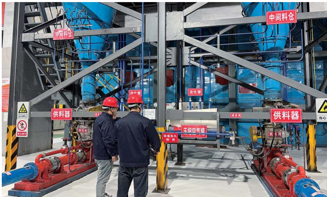
浆水泉热源厂燃煤供热设备关停。
