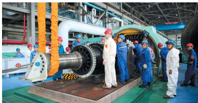
机组安全运行，供热才能可靠稳定。这是检修人员在进行发电机抽转子工作。
