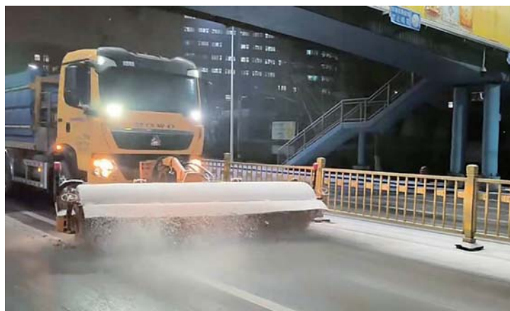
作业车正在除雪。
