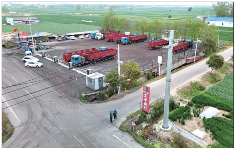
持续提升用电保障能力。
