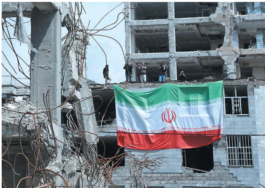
20日,在伊朗首都德黑兰,伊朗国旗悬挂在遭美以空袭严重损毁的居民区建筑物上。 新华社发
