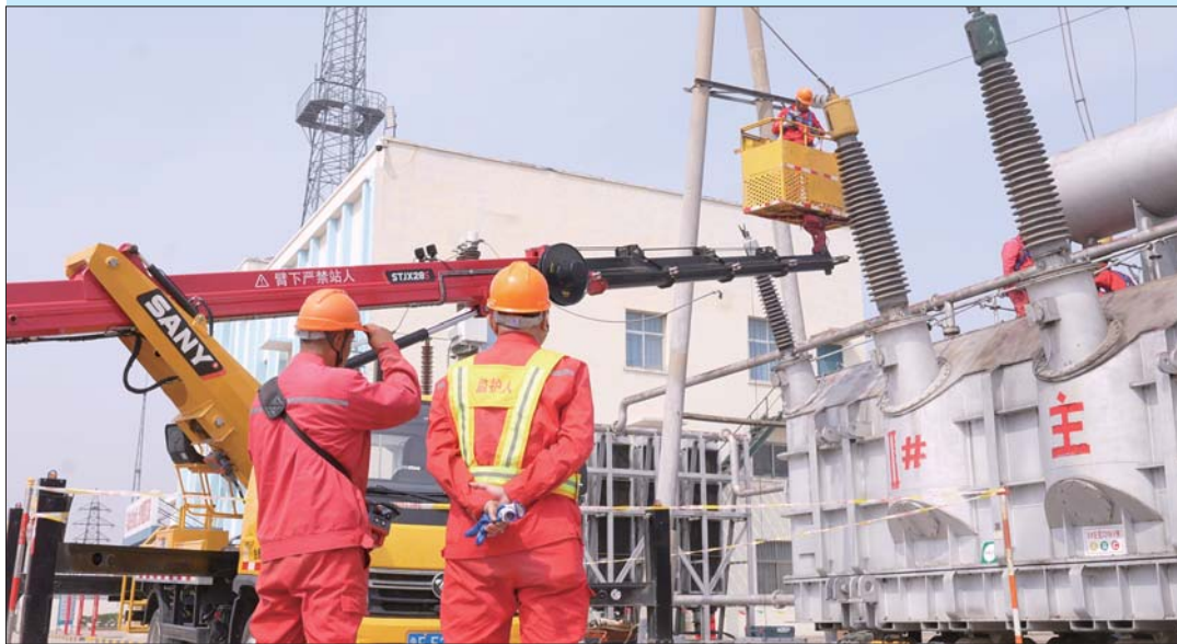
员工对220千伏九分场变电站2号主变压器进行检修作业。
