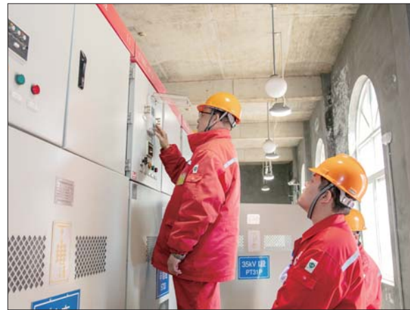
调试人员对开关柜运行状态进行调试。 通讯员 郭玉茵 摄
