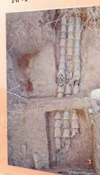
山顶建筑基址东北部排水管道
