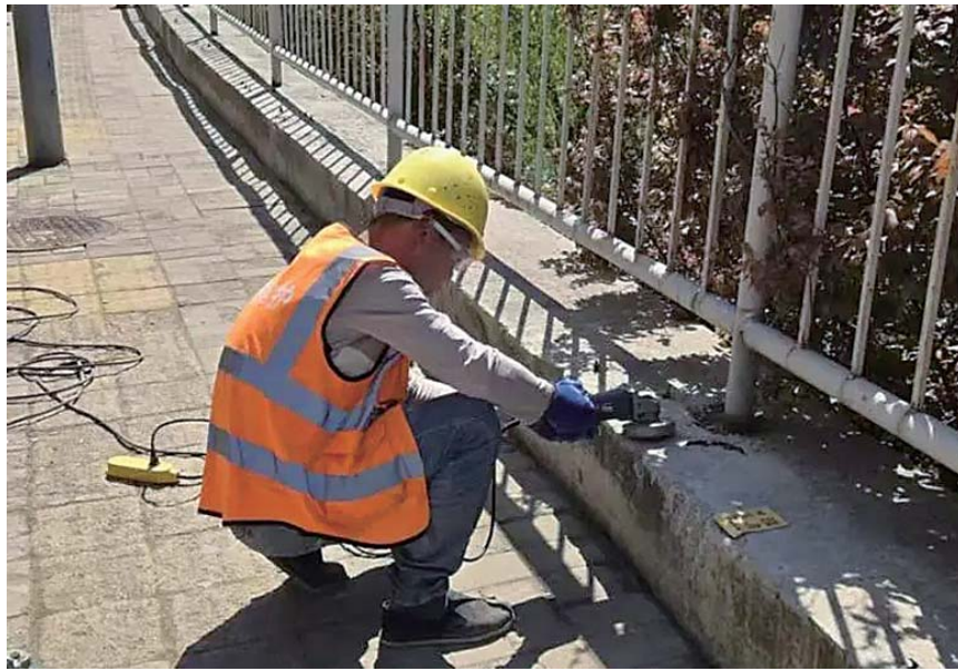
近日，济南市城乡交通运输局组织施工人员清除马路地钉。受访者供图
