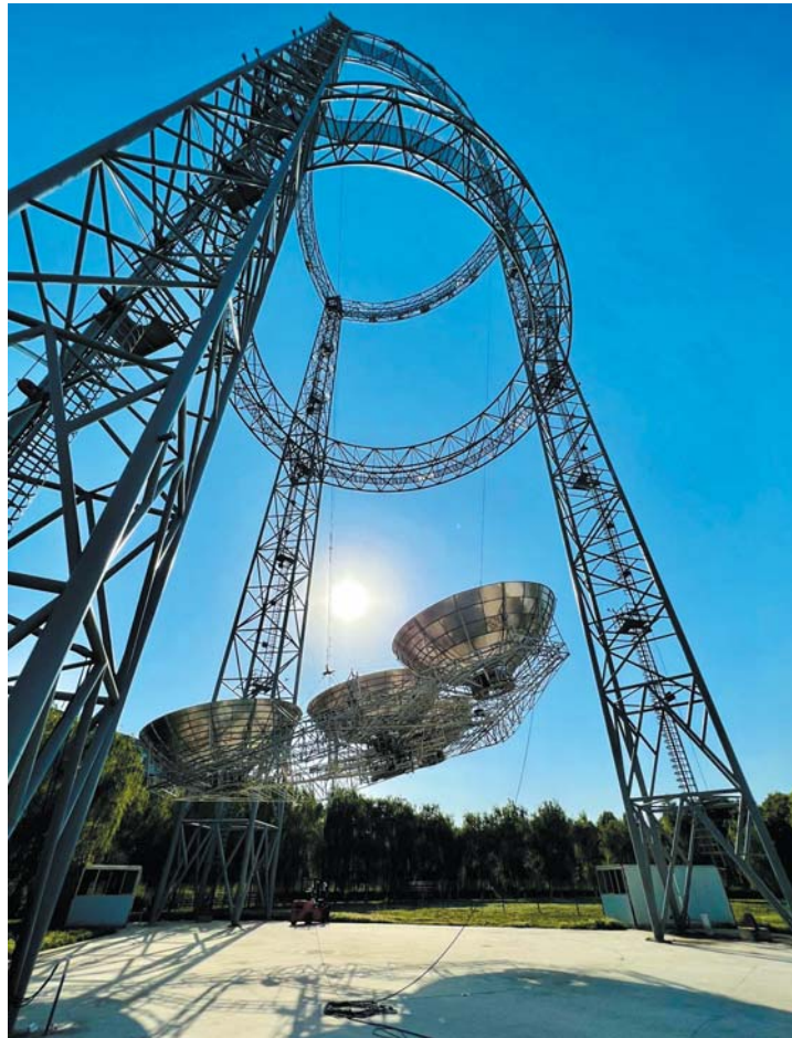
“逐日工程”——欧米伽空间太阳能电站地面验证系统。
