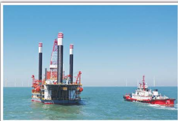
胜利295实施平台拖航精就位作业。
