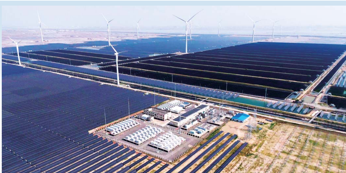
位于鲁北盐碱滩涂地风光储输一体化基地的寿光营里恒远光伏电站
