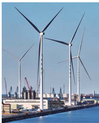
全国首个“零碳港口”——潍坊港
