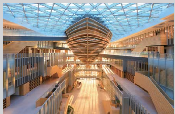
西海岸校区综合体
