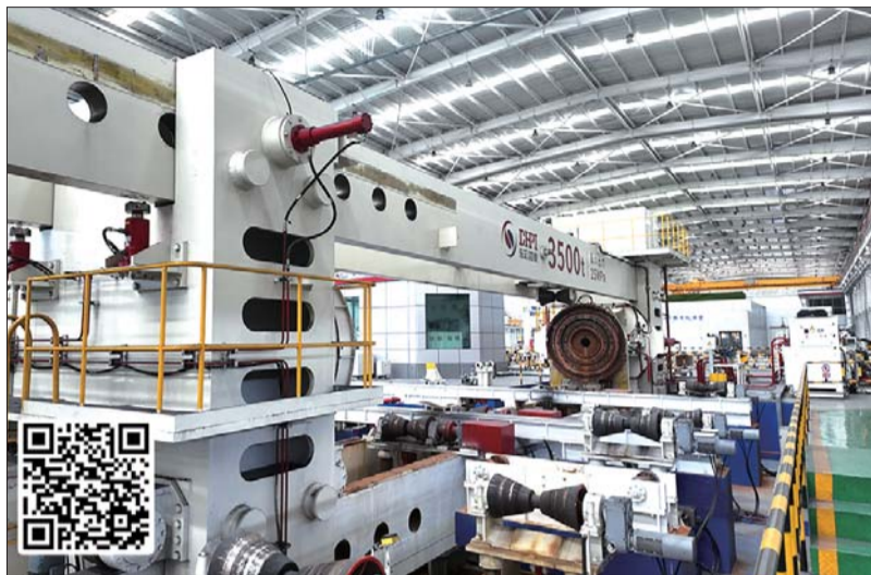
东宏管业管道智造园W3车间。
