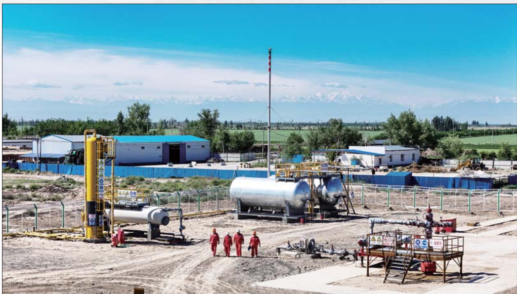
一代代新春人接续奋斗，在荒原深处走出一条安全与环保并重、开发与生态共生之路，戈壁荒滩崛起现代化油气场站。
