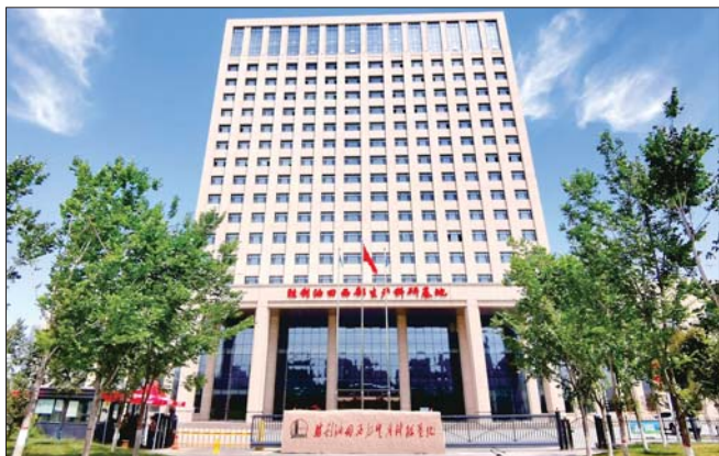
胜利油田乌鲁木齐生产科研基地作为西部油气生产运行和勘探开发核心科研中枢，紧盯生产节奏、抓实一体化运行，集聚科研骨干攻坚关键技术，高效助推油气增储上产。
