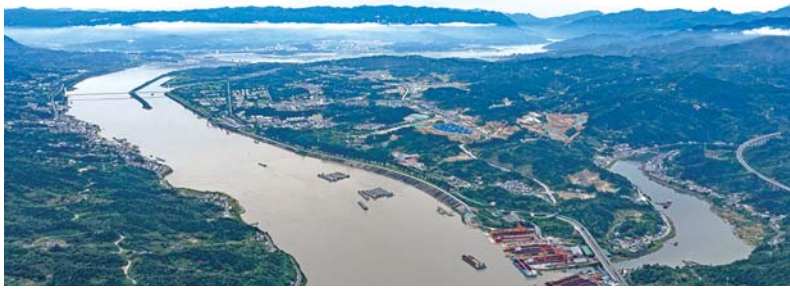
6月8日拍摄的三峡水运新通道工程三峡枢纽新通道施工现场。 新华社发
