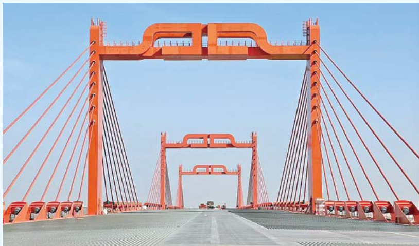
施工中的济阳黄河公铁两用桥。 通讯员 魏圣曜 摄
