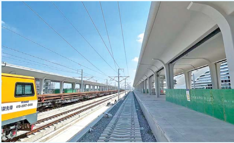
建设中的济滨高铁商河站。 记者 王瑞超 摄
