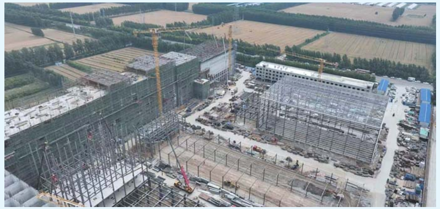
好面缘食品产业园项目现场。
