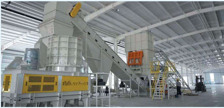
润泰环保新厂房里,自动化冰箱拆解线正做着安装调试。
